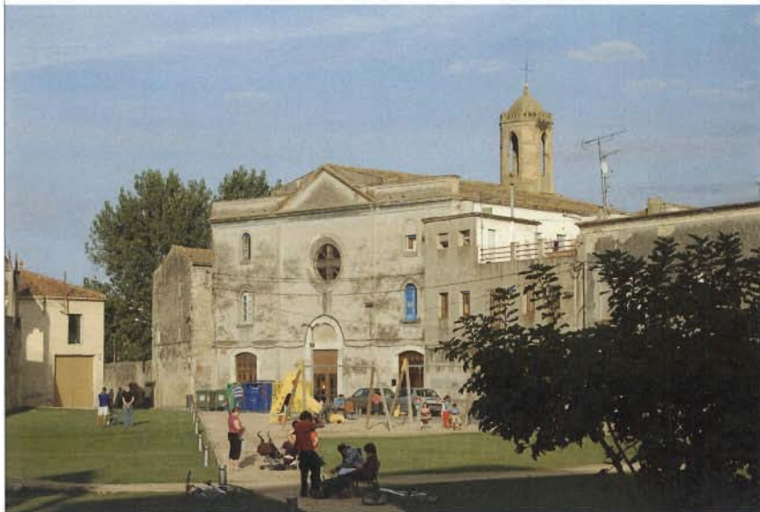
FAÇANA PRINCIPAL DE LA PROVIDÈNCIA
